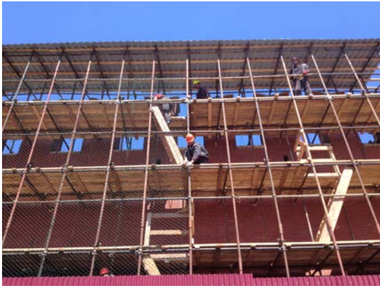
Bauen an der roten Mauer
